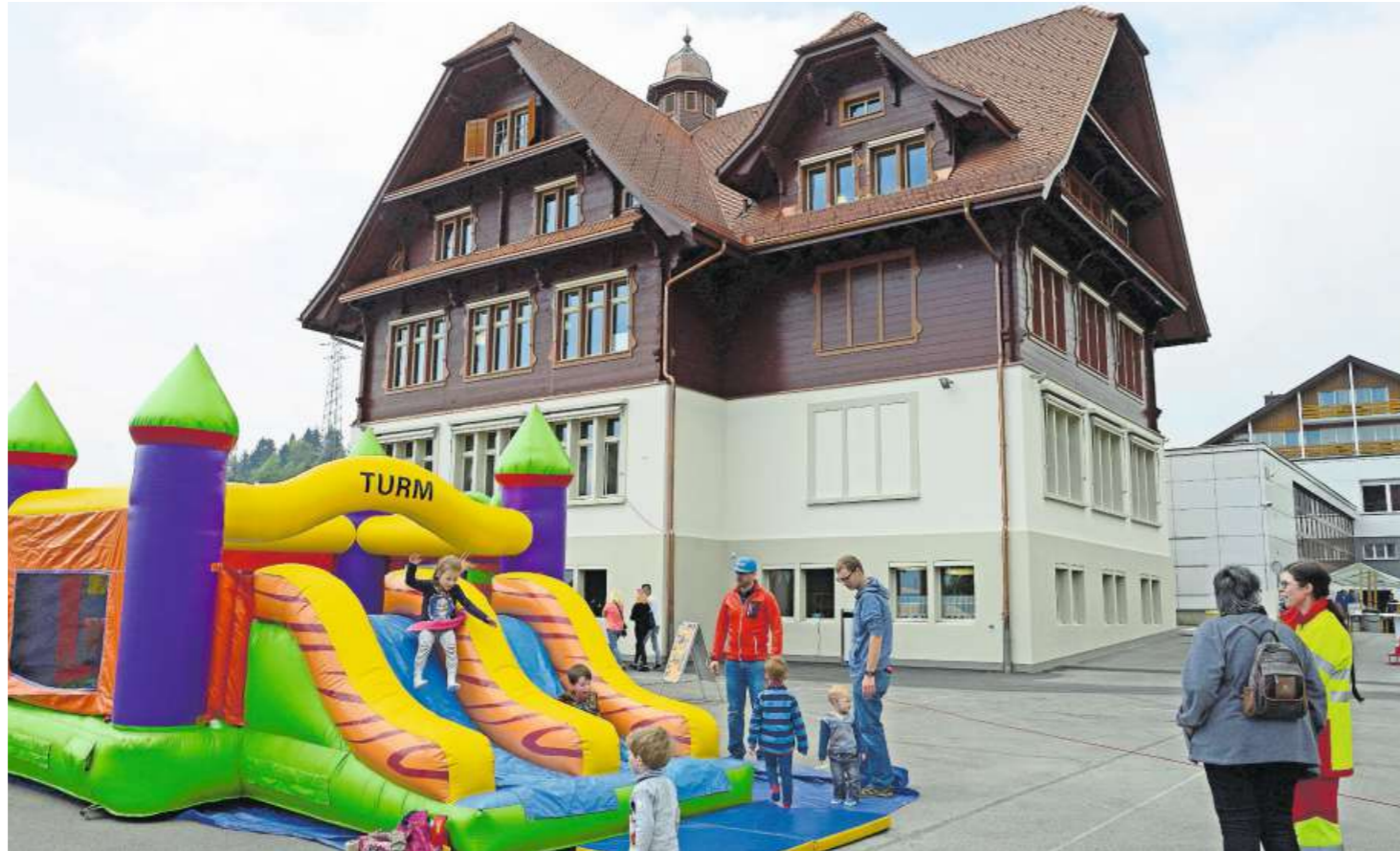
Das vollständig renovierte Schulhaus 1, rechts dahinter das Schulhaus 2.
